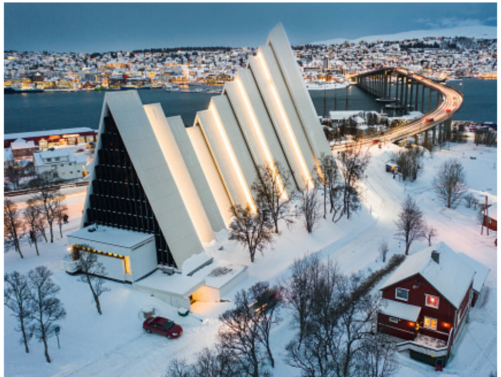
Tromsø Bridge Tromsøbrua, Norway
